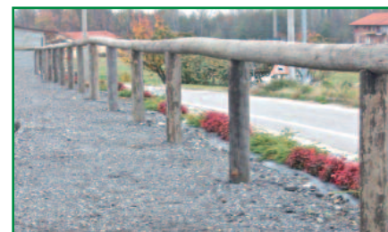
Il nuovo parcheggio di frazione San Grato
